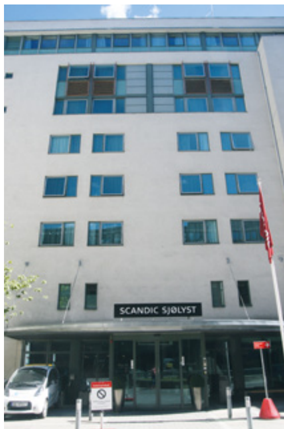
Scandic Sjølyst har ikke hatt feilutløsning av inergen-anlegget sitt.
