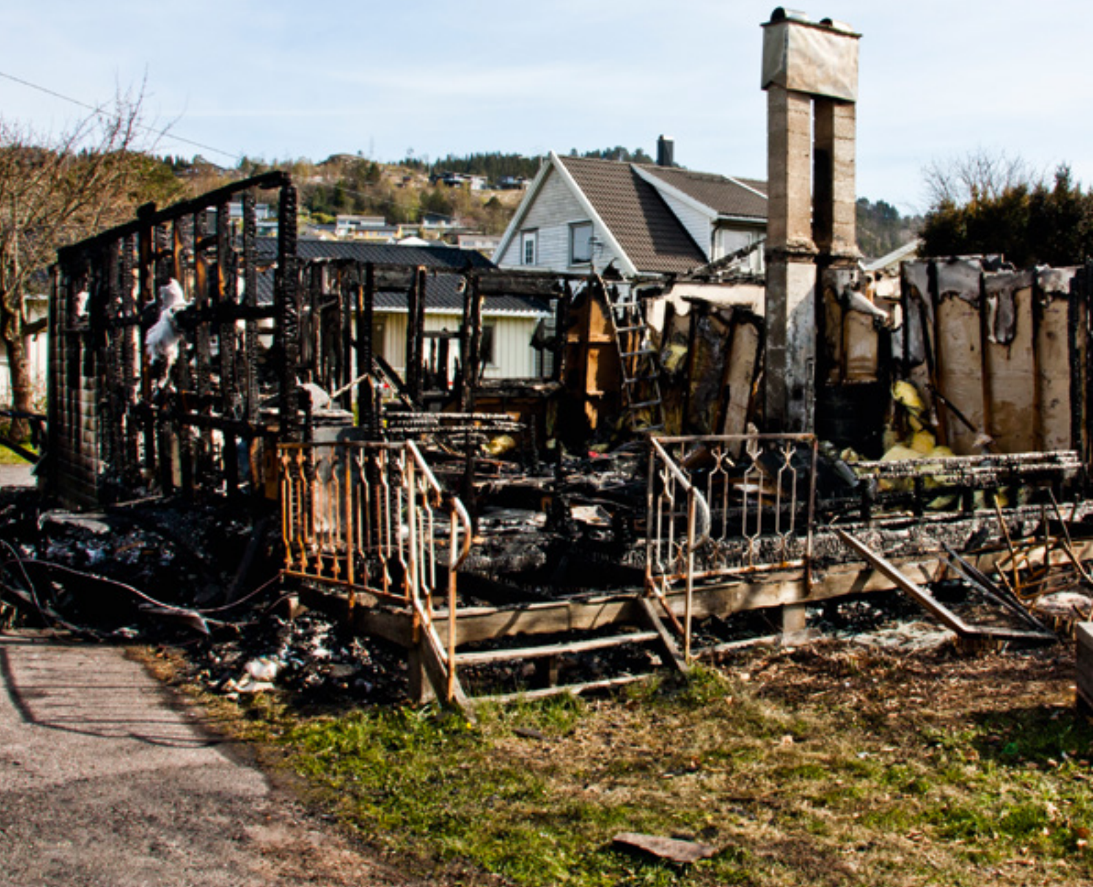
Det var i denne leiligheten brannen startet. Brannårsaken er ukjent. Brannen spredte seg raskt over useksjonerte loft.
